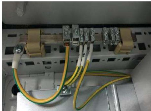
图 3 仪表盘柜的保护接地汇流排
