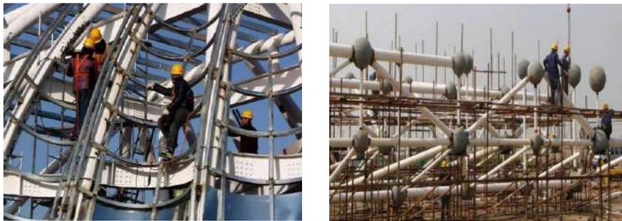
图2 桁架焊接
