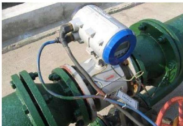
图1 电磁流量计现场接地
