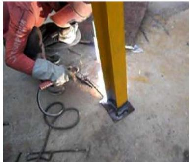
图 5 工字钢及钢板现场焊接图
