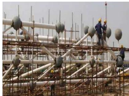
图3 焊接球节点焊接
