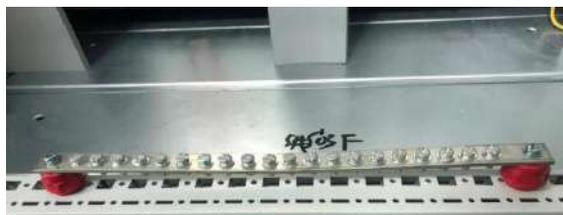
图 6 仪表盘柜的工作接地汇流排
