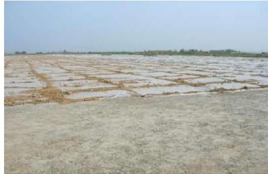
图3 塑料薄膜覆盖养护
