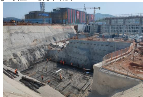
图 1 现场基坑情况
