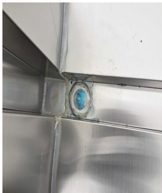
图4 屋面伸缩缝构造底板（附落水口）实体
