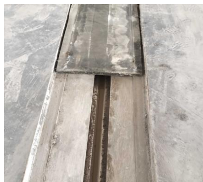
图2 楼面伸缩缝构造实体
