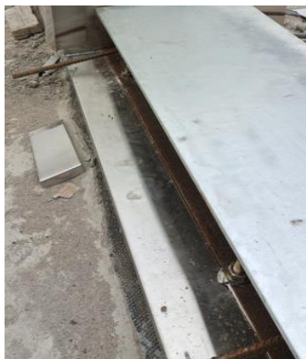
图1 停车屋面伸缩缝构造——工字钢及盖板
