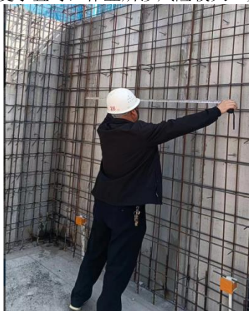
图2 施工人员操作
