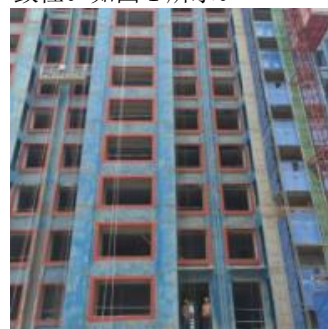
图 1 外墙保温层施工现场
