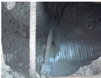
图5 波纹管修复
