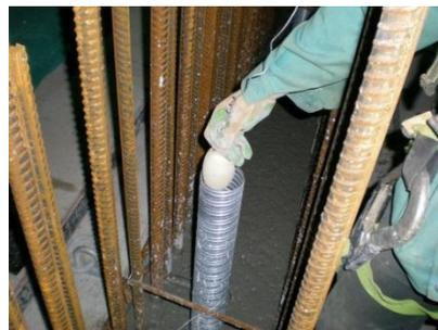
图4 波纹管通管
