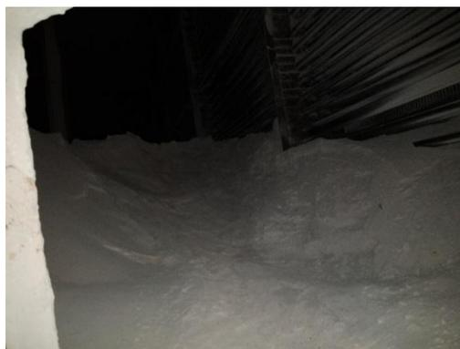
图 11 B 空预器烟气出口爬坡段积灰严重，深度约 2mm 图 12 B 低温省煤器内部烟道积灰严重高度约 1.5m
