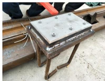
图 4.2.1-1 底座钢板焊接
