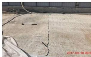
基坑南侧硬化面纵向裂缝 14m 长 4.5mm 宽
