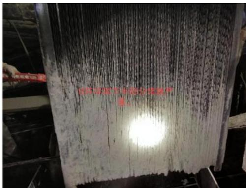
图 3 B 环下层元件的堵塞情况
