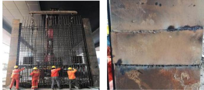
**图 19 钢筋笼及工字钢接头连接图**
