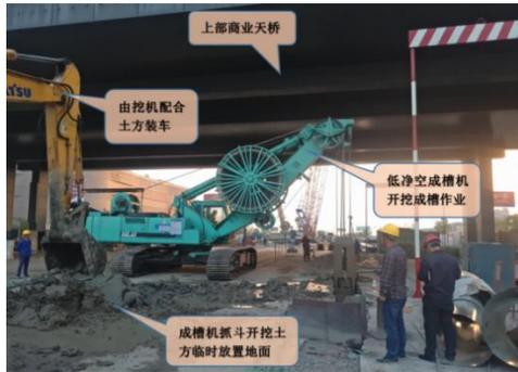
图 12 天桥下低净空成槽施工
