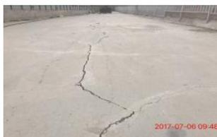
基坑南侧硬化面开裂 6m 长，5mm 宽
