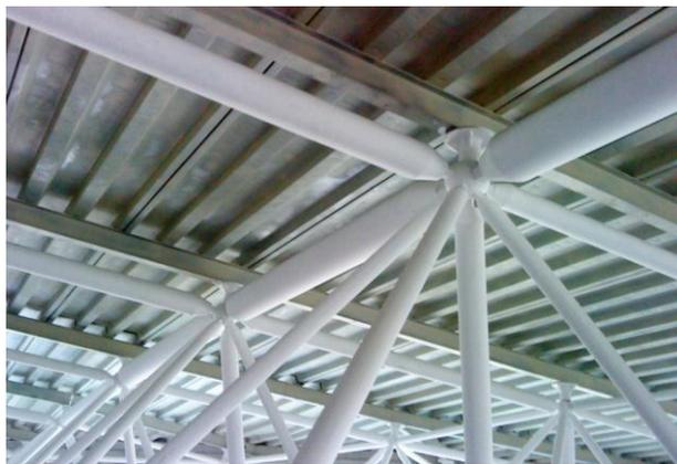
图2 大跨度钢结构网架节点多
