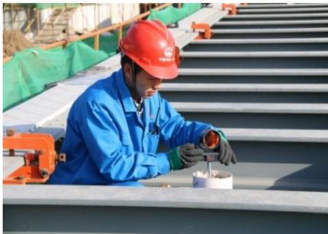
图 4.2.5-1 控制基桩安装棱镜
