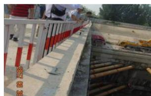
围护桩、挡墙向基坑内变形明显
