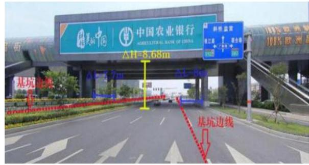
图2 天桥与车站基坑关系图
