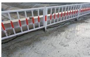
基坑南端头硬化路面与挡墙竖向裂缝，最大时宽 5cm
