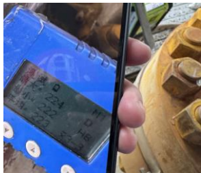
图 4 焊缝硬度检查
