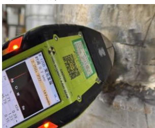
图 3 焊缝光谱检查
