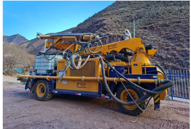
图3 HP3017G 湿喷机械手施工
