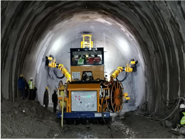
图2 DJ3E 凿岩台车施工现场
