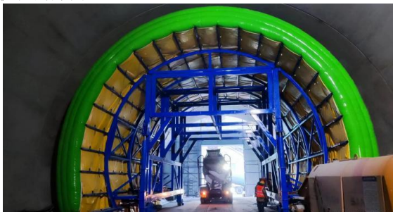
图 4 智能衬砌台车现场应用
