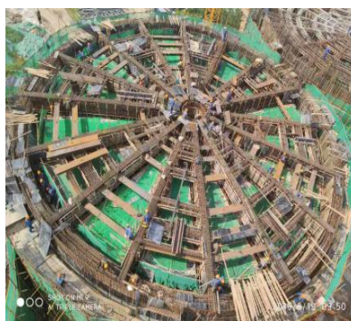
图 8 仓顶板施工、浇筑混凝土
