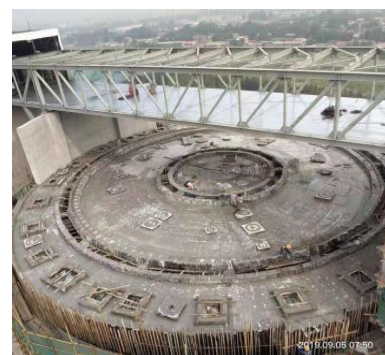
图 8 仓顶板施工、浇筑混凝土
