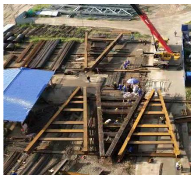
图 6 仓顶板型钢单元及仓下拼装图
