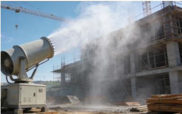
图2 喷雾抑尘设备作业现场图
