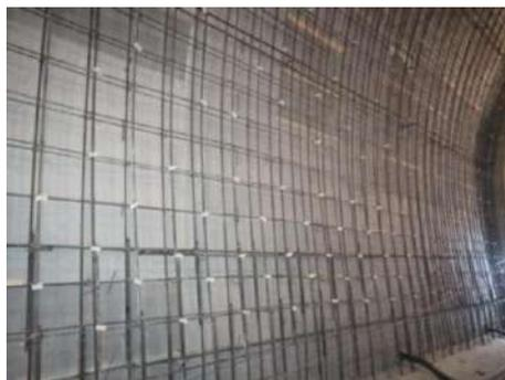
图 5 隔热套衬防裂钢筋绑扎
