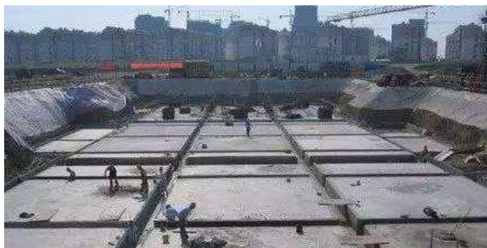
图 1 筏板基础施工
