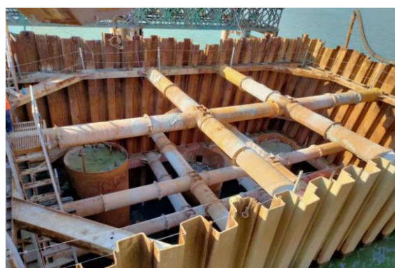
图 5-1 围堰止水效果
