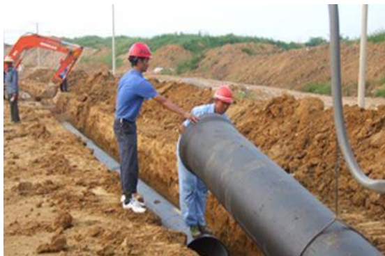
图 2 给排水管道安装
