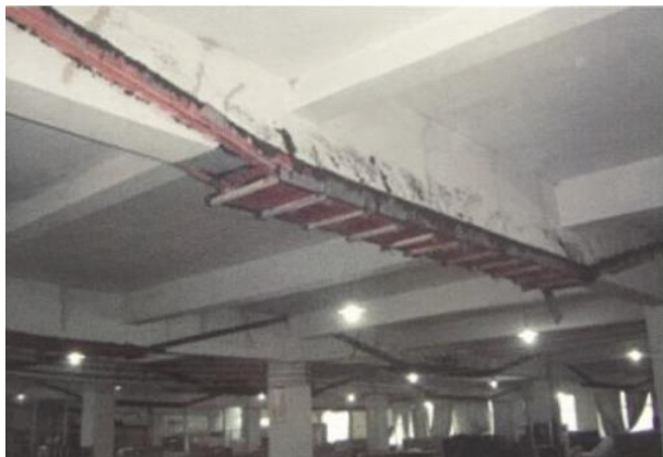
图1 预应力在混凝土浇筑工程的应用
