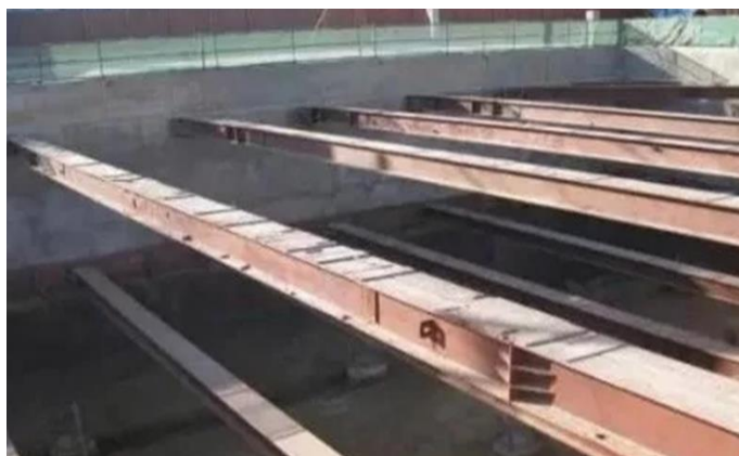
图2 钢板桩支护结构
