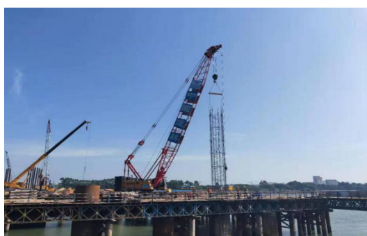
图7 钢筋笼安装
