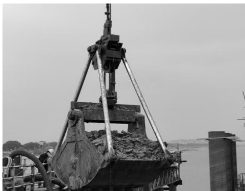
图 4-5 抓斗开挖施工图
