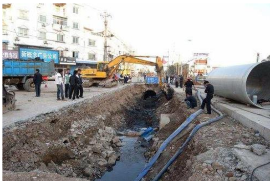
图 1 沟槽开挖
