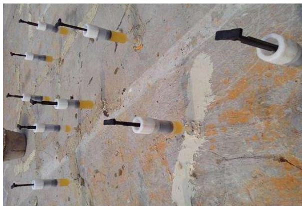
图 2 混凝土结构注浆效果
