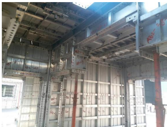
图 1 铝模板试拼装及编码
