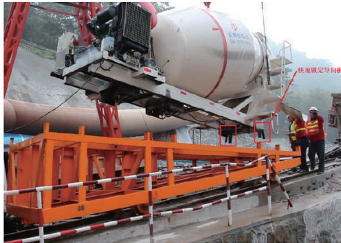
图4.2-2利用导向板有快速定位锁定
