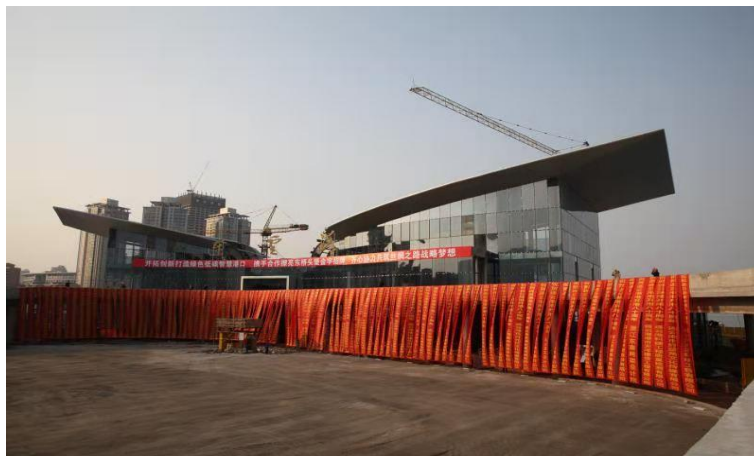
图2 连云港国际客运站工程荣获2019年度江苏省优质工程奖“扬子杯”，是为连云港港口开港八十周年献礼的重点工程建设项目
