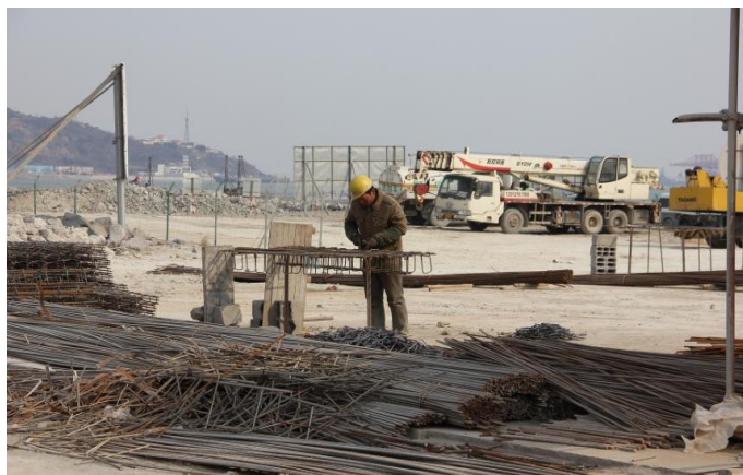
图3 工人绑扎钢筋
