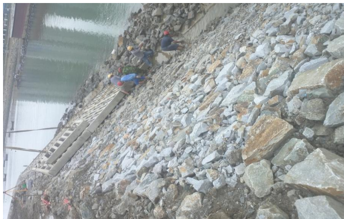
图 6 人工找平坡面
