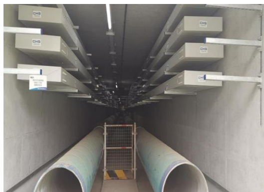
图2 综合管廊综合管管线路布置图
