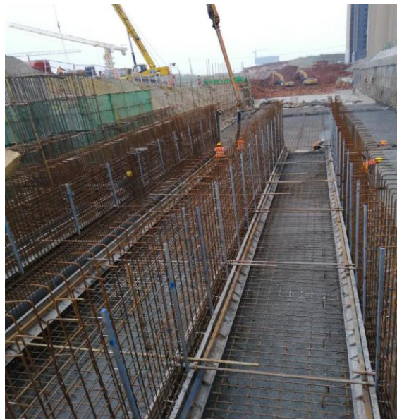
图3 综合管廊明挖现浇法施工现场照片
