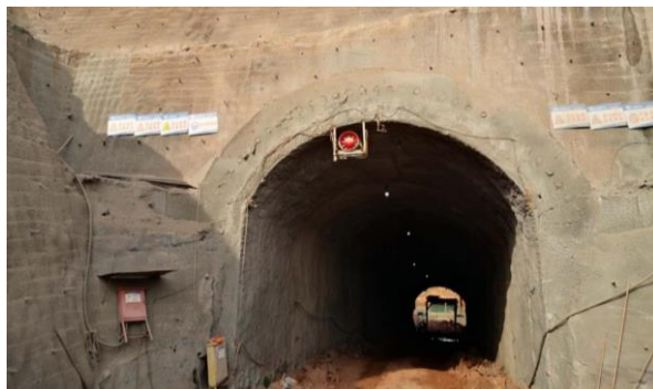
图4 综合管廊浅埋暗挖施工现场照片
