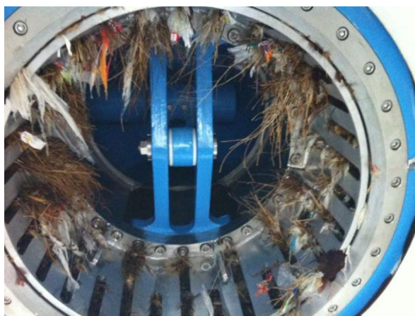
图1 高昌输水管道调流阀堵塞情况（孔宽40mm）
