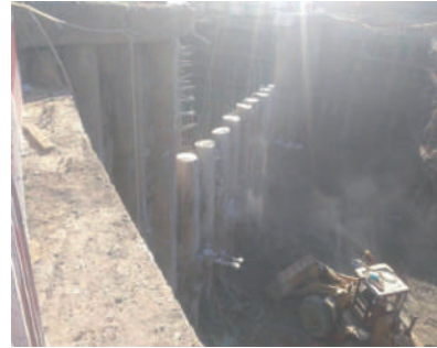
图6: 切割现场实景图
