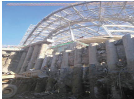
图5: 切割现场实景图
