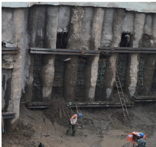
图4：承压水层流砂处理实景图
