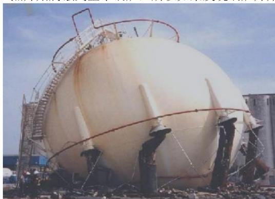
图1 腐蚀裂纹导致的球罐倒塌
