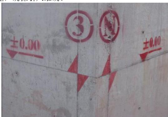
图2 楼板、筏板防水保护层轴线及构件边线弹设样例
