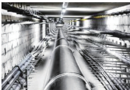
图1通信管道管井铺设地下图
