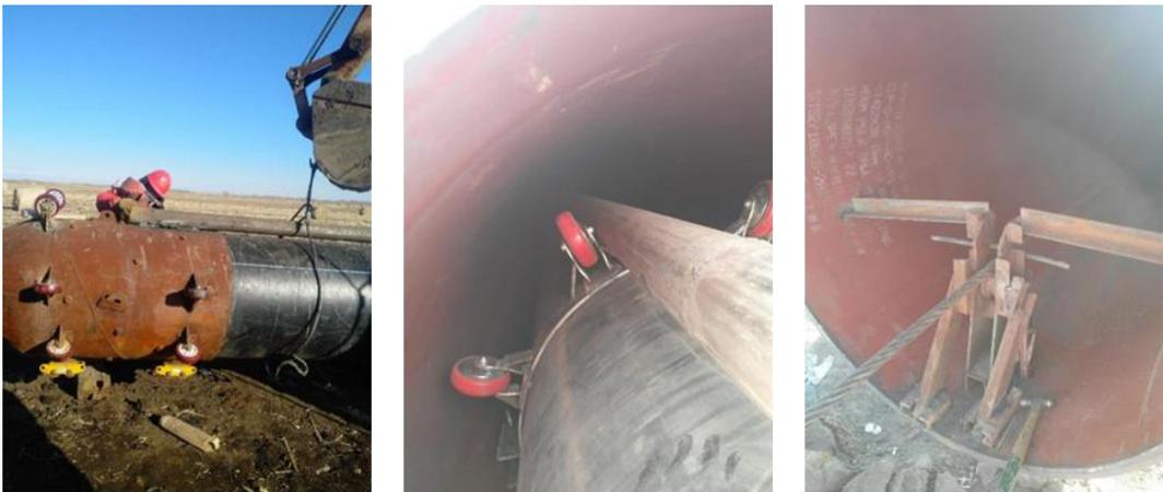
图3 PE管回拖过程图片
