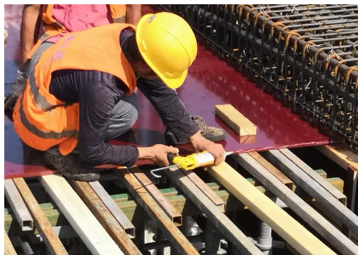
图 4 顶板拼缝处打密封胶
