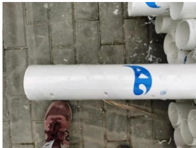
图 3 PVC 管钻孔
