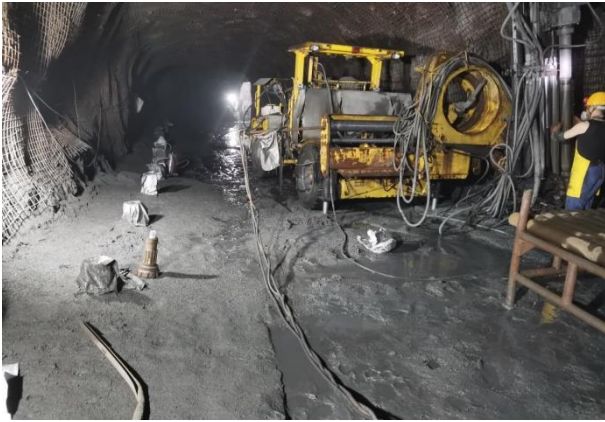
图4 Simba364 潜孔钻机在辽宁本溪龙鑫矿业有限公司井下施工钻孔
