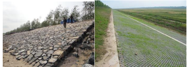
图9 格宾石笼护坡，连锁块护坡
