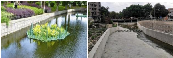
图6 浆砌石挡墙护岸，混凝土挡墙护岸
