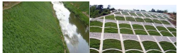
图10 草皮护坡，拱形护坡
