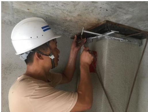
图5 洞口补洞辅助装置安装过程
