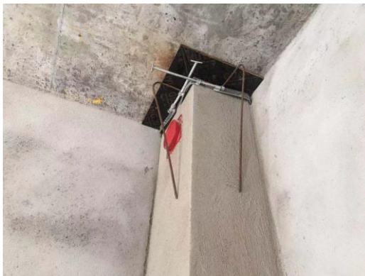
图6 洞口补洞辅助装置安装完成
