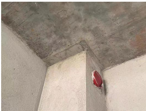
图7 洞口浇筑成型
