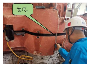
图14 卷尺测量汽缸水平
