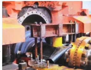
图 17 百分表检测汽缸水平
