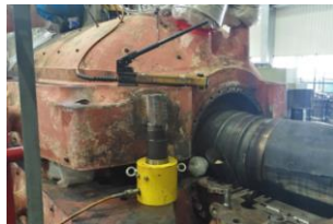
图 4 外缸支撑及顶缸示意图
