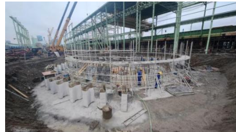
图12 刃脚施工
