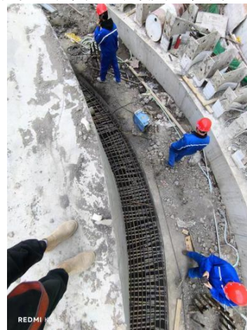
图 17 环梁与井壁钢筋绑扎
