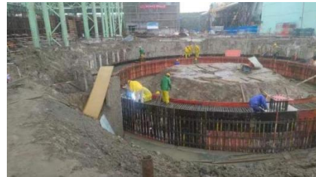
图11 环梁施工
