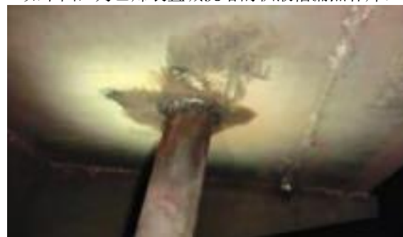
图2 积液槽的漏点补焊
