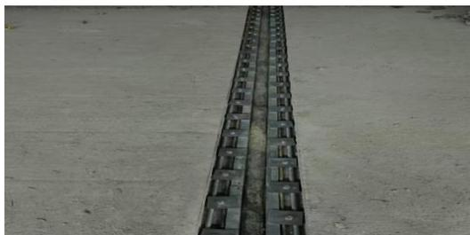
图3 可卸式止水带安装
