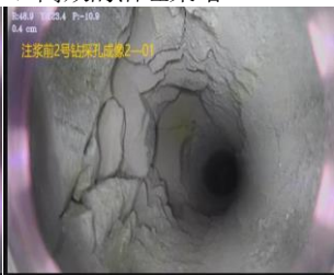
图2 2号孔注浆前成像图
