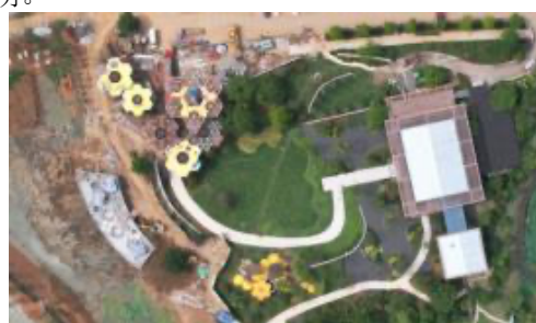
图4 一期施工完成后现场鸟瞰图
