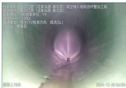
图 2 修复后 CCTV 检测
