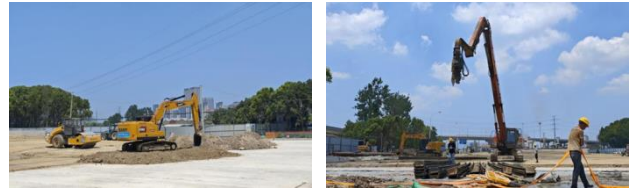
图 6 浇筑场地现场准备
