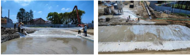
图 11 流态固化土覆膜与洒水养护
