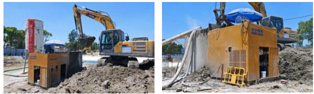
图 8 流态固化土现场制备
