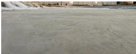
图 12 浇筑 10h 后硬化效果(上人无印记)
