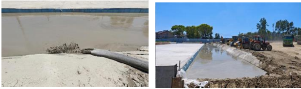
图 10 流态固化土泵送浇筑与浇筑后的自流平效果
