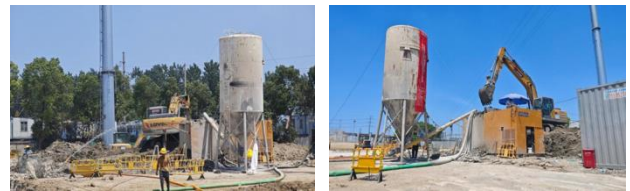
图 7 流态固化土设备现场组装
