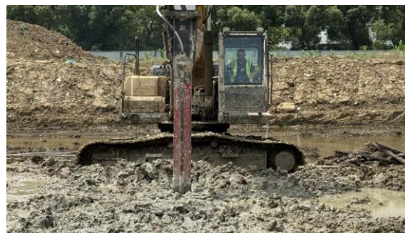
图5 强力搅拌设备原位拌合施工作业
