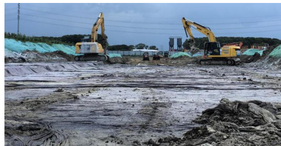
图7 土工布覆盖与洒水养护
