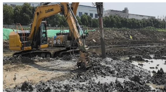
图6 平板振动器收面施工作业
