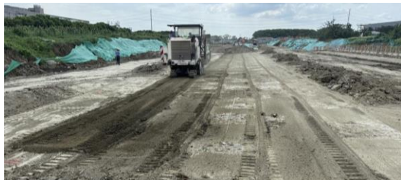
图 8 铣刨机对场地标高进行修整
