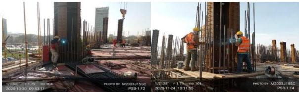
图8 现场钢柱焊接
