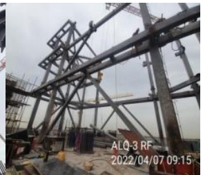
图12 桁架安装
