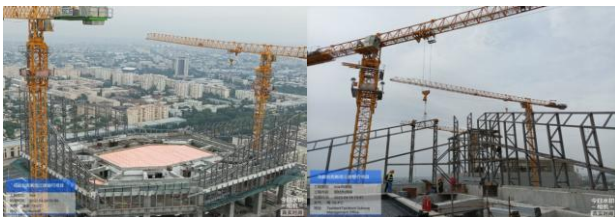
图6 现场塔吊设置及吊装
