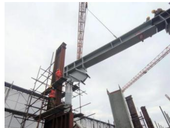
图11 桁架层粘滞阻尼器拼装施工
