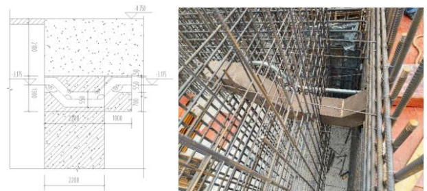
图3 典型穿过防护墙预埋图
