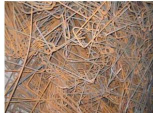
图7 钢筋材料浪费严重
