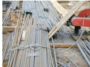
图5 现场钢筋加工安全文明施工差
