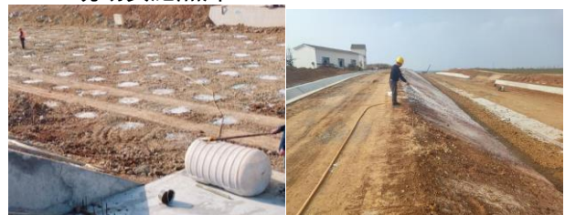
图 2 地基喷洒 CMA 改性剂
