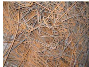
图7 钢筋材料浪费严重
