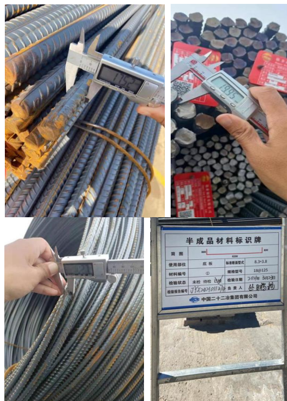
图 13 钢筋原材料进场验收及材料标识
