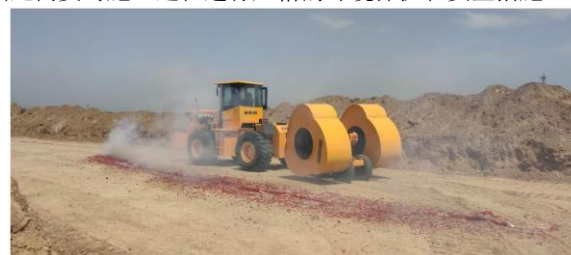
图1 压路机在对路基进行压实操作
