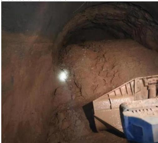
图1 XSDK278+406 掌子面(突泥涌水后)
