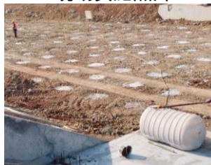
图2 地基喷洒 CMA 改性剂
