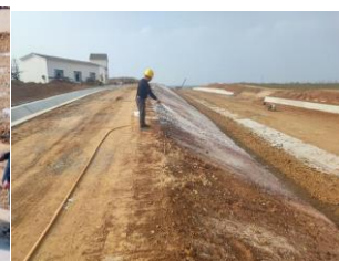
图3 边坡喷洒 CMA 改性剂
