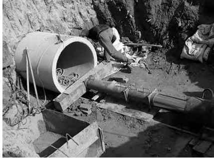
图2 顶管施工示意图
