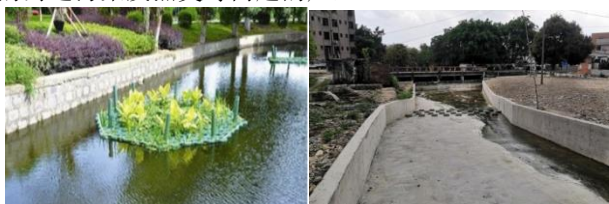
图6 浆砌石挡墙护岸,混凝土挡墙护岸
