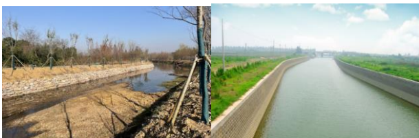
图8 叠石护岸,生态砌块护岸
