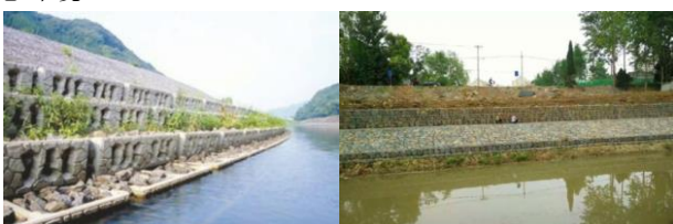
图7 箱型砌块护岸,格宾石笼护岸
