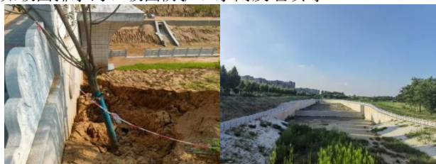
图4 河道坡面冲刷, 规划疏挖河道枯水期现状
