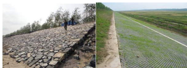
图9 格宾石笼护坡,连锁块护坡
