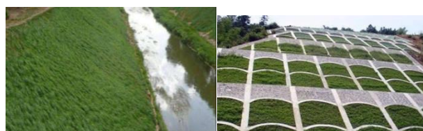
图10 草皮护坡,拱形护坡
