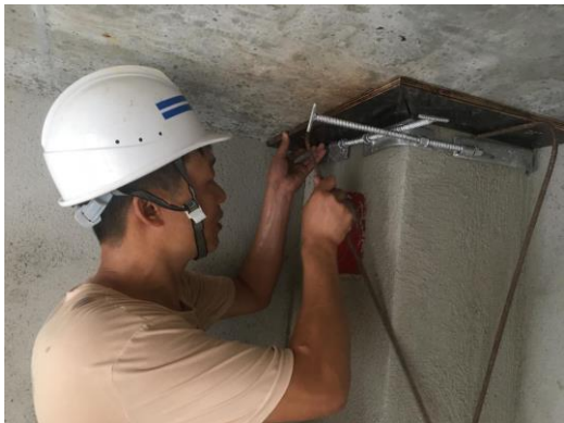
图 5 洞口补洞辅助装置安装过程
