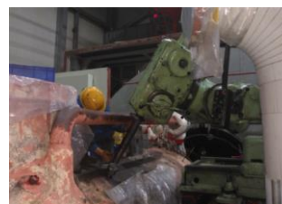
图 7 外缸外缸顶开螺孔加工场景
