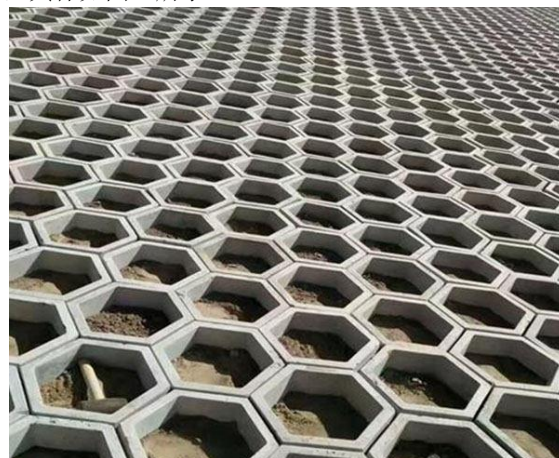
图 2 六角块护坡施工
