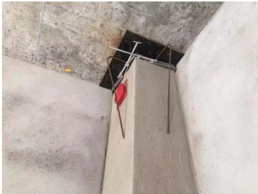
图 6 洞口补洞辅助装置安装完成
