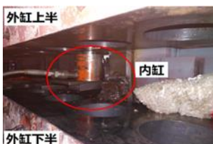
图 5 辅助支撑板顶缸示意图
