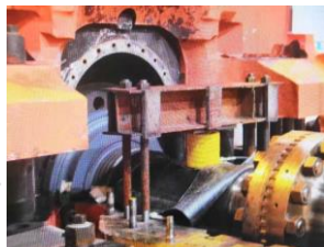
图 17 百分表检测汽缸水平
