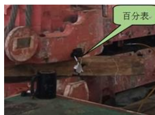
图15 百分表检测汽缸水平
