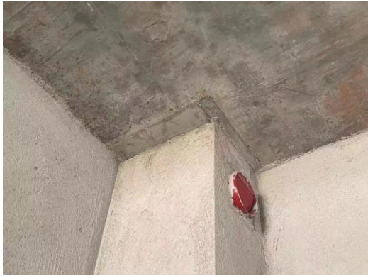
图 7 洞口浇筑成型
