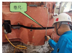
图14 卷尺测量汽缸水平
