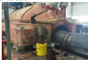
图 4 外缸支撑及顶缸示意图
