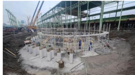
图12 刃脚施工
