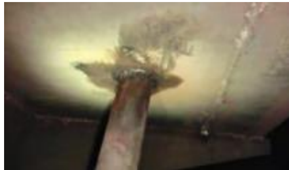
图2 积液槽的漏点补焊
