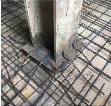
图5 楼板立柱支撑加固现场照片
