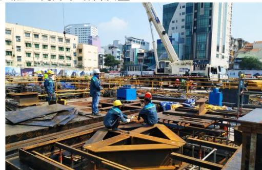
图 4 钢柱帽现场施工照片
