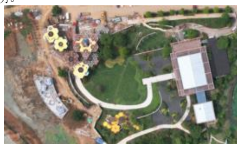
图4 一期施工完成后现场鸟瞰图
