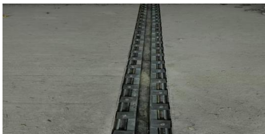
图3 可卸式止水带安装
