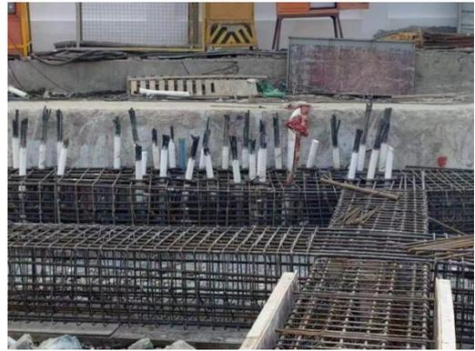
图3 可回收无黏结预应力筋图
