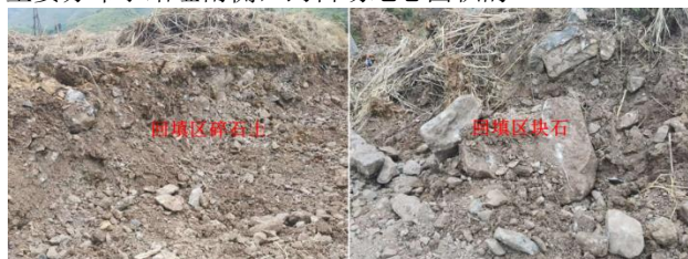
图 1 站址回填碎石及块石
