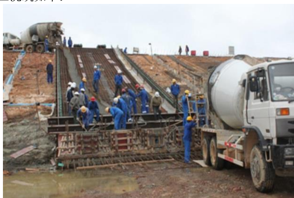
图2 混凝土浇筑
